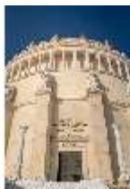
KeBf.I, Außenfassade, DI013662, BSV-
