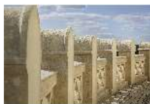
KeBf.I, Balustrade des oberen Umgangs, DI014200, BSV-
