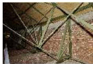
KeBf.II, Dachboden, DI014214, BSV-
