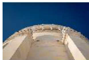
KeBf.I, Blick die Außenfassade hoch, DI013607, BSV-
