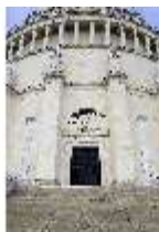
KeBf.I, Außenansicht Süd- Osten, DI014267, BSV-
