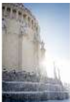
KeBf.I, Außenfassade, DI013660, BSV-
