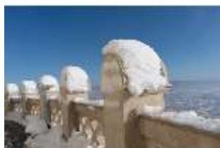
KeBf.I, Äußerer Umgang im Winter, DI013649, BSV-
