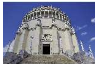
KeBf.I, Außenansicht Süd- Osten, DI014262, BSV-
