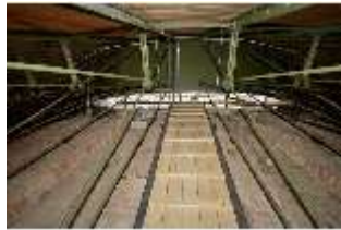
KeBf.II, Dachboden, DI029153, BSV
