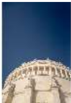
KeBf.I, Außenfassade, DI013606, BSV-
