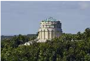
KeBf.I, Außenansicht Nord- Osten, DI014244, BSV-
