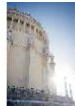
KeBf.I, Außenfassade, DI013659, BSV-
