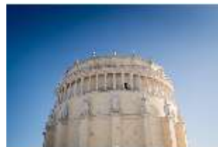
KeBf.I, Außenfassade, DI013648, BSV-
