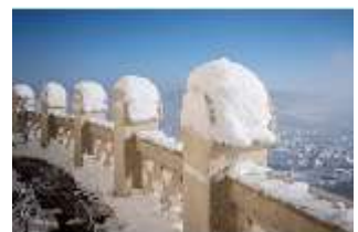
KeBf.I, Äußerer Umgang im Winter, DI013647, BSV-
