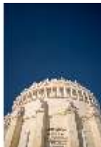
KeBf.I, Außenfassade, DI013613, BSV-
