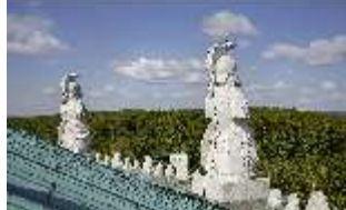
KeBf.I, Trophäen auf dem Dach, DI014215, BSV-
