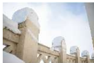
KeBf.I, Äußerer Umgang im Winter, DI013650, BSV-
