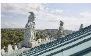
KeBf.I, Trophäen auf dem Dach, DI014219, BSV-
