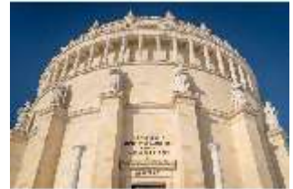
KeBf.I, Außenfassade, DI013605, BSV-
