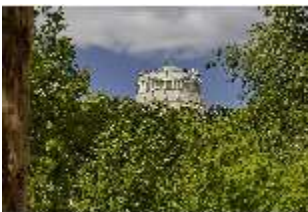
KeBf.I, Südfassade, DI014462, BSV-
