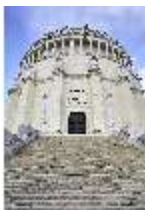
KeBf.I, Außenansicht Süd- Osten, DI014266, BSV-
