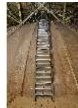
KeBf.II, Dachboden, DI014211, BSV-
