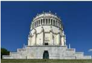
KeBf.I, Außenansicht mit Unterbau, Eingangsseite, DI011097, BSV-
