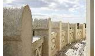
KeBf.I, Balustrade des oberen Umgangs, DI014197, BSV-
