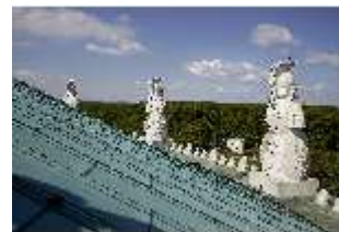
KeBf.I, Trophäen auf dem Dach, DI014217, BSV-
