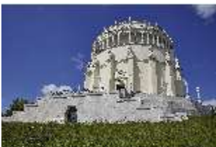
KeBf.I, Außenansicht Süd- Osten, DI014260, BSV-
