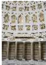
KeBf.II, Säulengalerie und Kuppel, DI014335, BSV-
