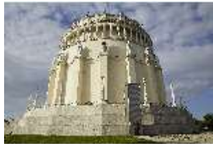
KeBf.I, Außenansicht Norden, DI014249, BSV-
