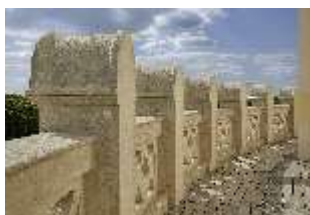
KeBf.I, Balustrade des oberen Umgangs, DI014199, BSV-
