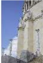
KeBf.I, Seitenansicht der Fassade, DI014270, BSV-
