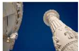
KeBf.I, Blick die Außenfassade hoch, DI013610, BSV-
