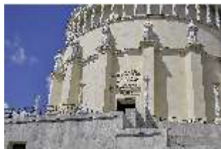
KeBf.I, Außenansicht Süd- Osten, DI014261, BSV-
