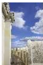
KeBf.I, Balustrade des oberen Umgangs, DI014202, BSV-
