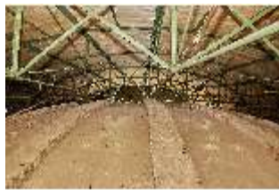
KeBf.II, Dachboden, DI014209, BSV-
